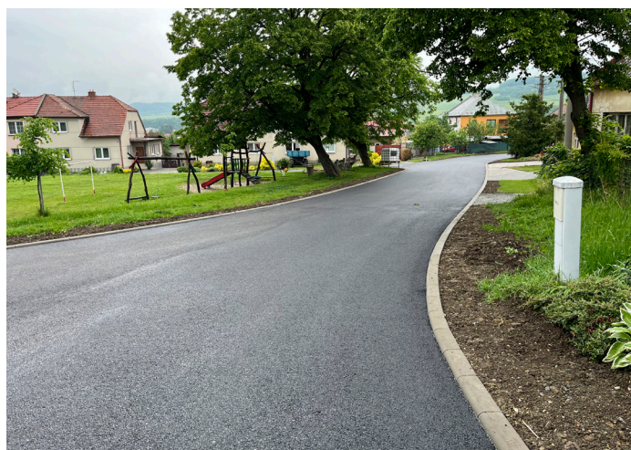
Silnice u Jarmeku
