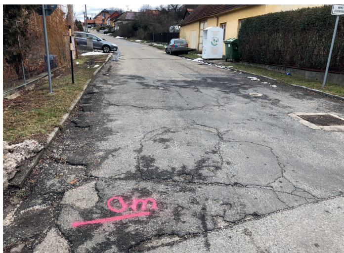
Ulice Pod hradem - před rekonstrukcí
