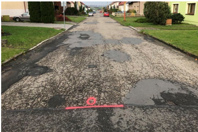
Výstavba místní komunikace, chodníku a veřejného osvětlení v ulici U školy
