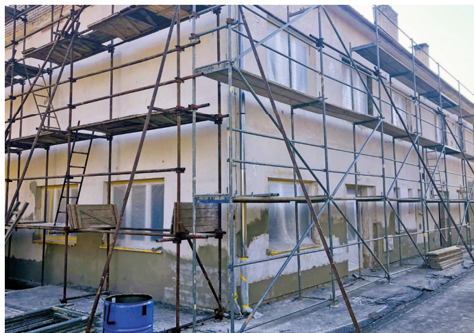
Rekonstrukce budovy pálenice
