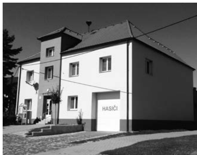
Zateplení budovy č.p. 428, oplocení dvora
