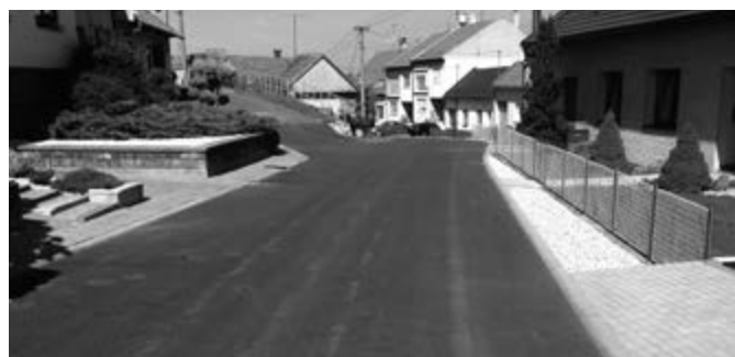
Oprava místní komunikace Na Hradě
