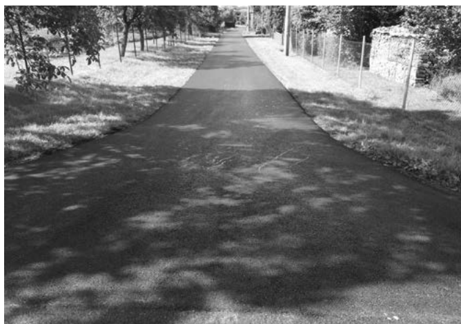
Obr. č. 2 - Oprava MK K Borkom
