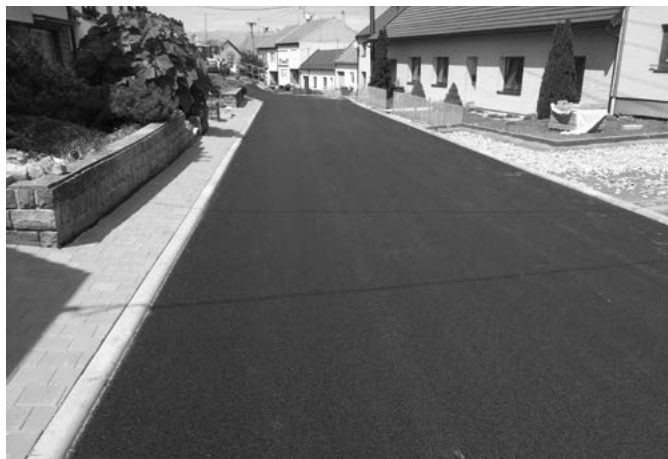
Obr. č. 1 - Oprava MK Na Hradě
