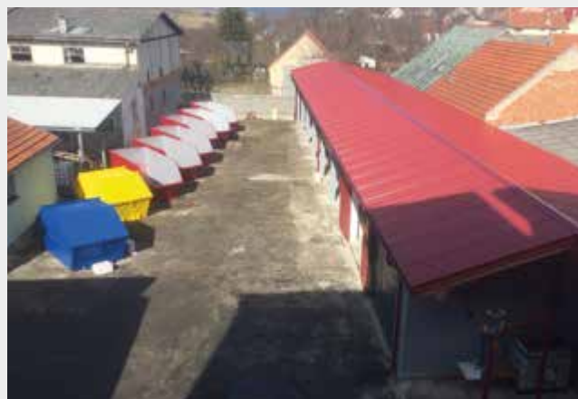
Sběrný dvůr po rekonstrukci
