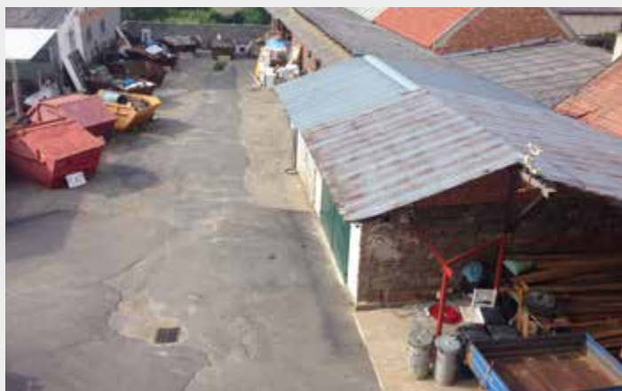
Sběrný dvůr před rekonstrukcí
