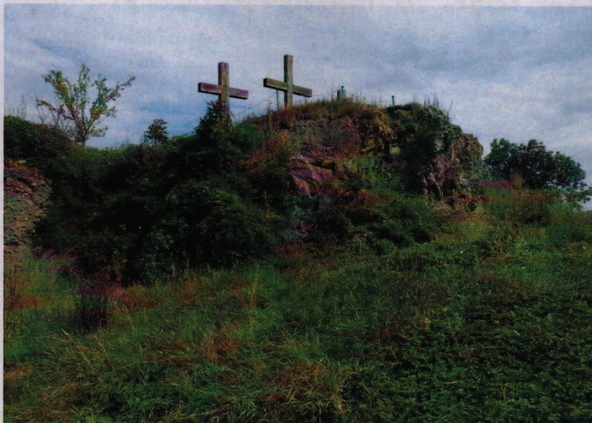
Zarůstání lomové stěny popínavými rostlinami a náletovými dřevinami
