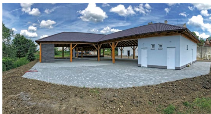
Zastřešení areálu pálenice
