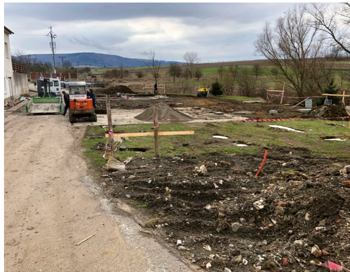
Stavba zastřešení na pálenici
