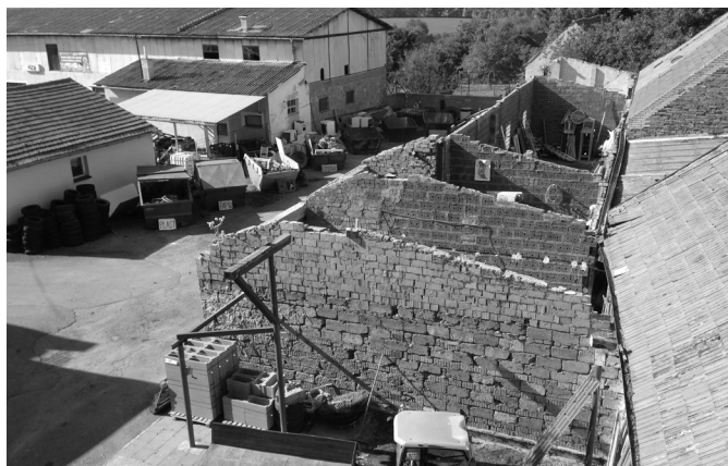
Probíhající modernizace sběrného dvora
