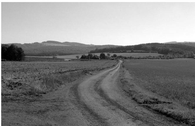
Opravená cesta z Ordějova do Suché Loze (Foto Marek Mahdal)
